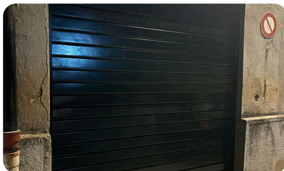
Rideau neuf motorisé, posé par nos équipes sur un garage sur rue.
